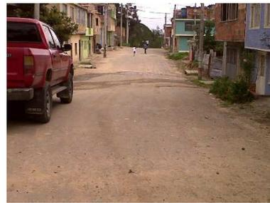
Foto N° 4. En este barrio, se evidencia la carrera principal únicamente como intervenida con el fresado estabilizado.
