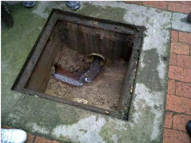
Foto N° 3. Se evidencia que existen cajas con mezcla de aguas negras y lluvias
