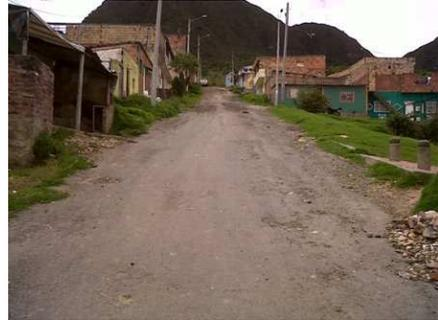
Foto N°2. Se evidencia la ejecución de obra de mantenimiento con fresado estabilizado, sin embargo este presenta a la fecha deterioro.
