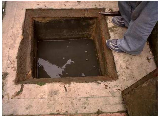
Foto N° 4. Se evidencian cajas de inspección con taponamiento y sin ningún drenaje de entrada o salida, es decir, se encuentran subutilizadas.
